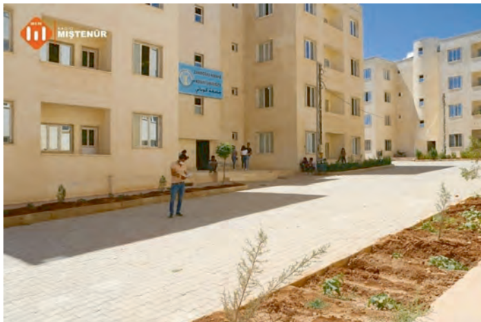
Neue Wohnungen entstehen
