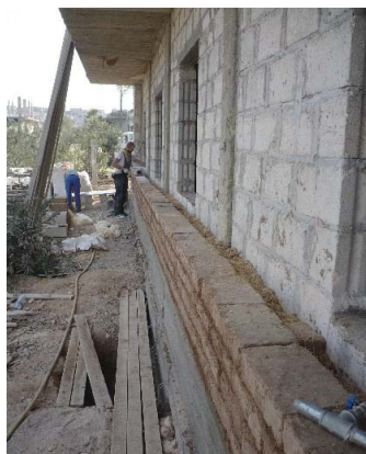
Links: Außenwand mit Lehmziegeln, an die sich nach innen zur Wärmedämmung Stroh und Hohlblocksteine anschließen.
