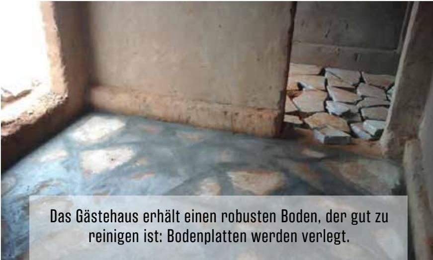
Das Gästehaus erhält einen robusten Boden, der gut zu reinigen ist: Bodenplatten werden verlegt.
