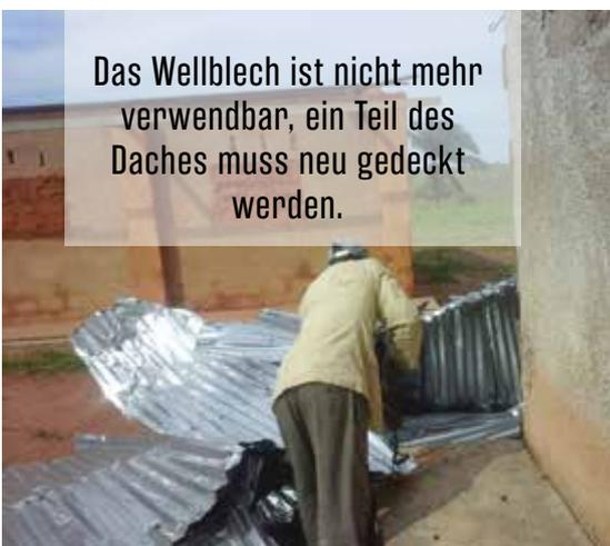
Das Wellblech ist nicht mehr verwendbar, ein Teil des Daches muss neu gedeckt werden.
